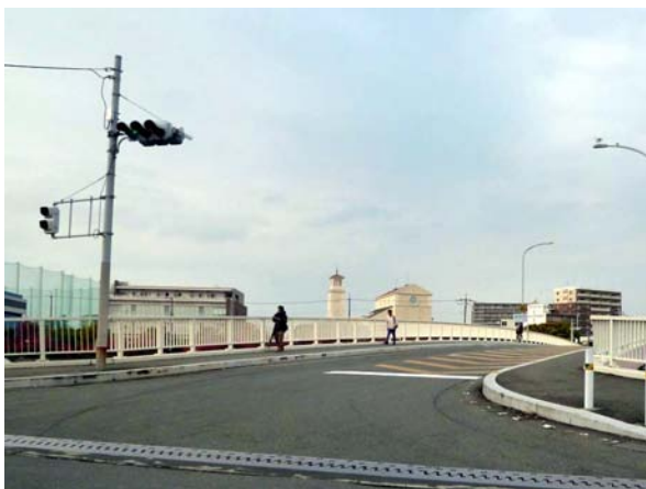
歩道橋の白い部分に柵を設置
