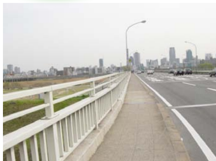
新淀川大橋（新御堂筋）の安全対策として、欄干の高さ（83cm⇒120cm）が高くなりました。
