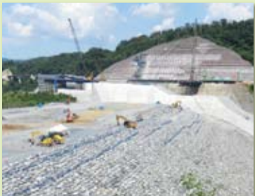
▲工事中の安威川ダム
